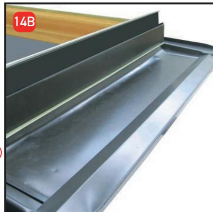
**IT** Inserire la parte superiore del raccordo (particolare D) sotto le lattronerie laterali e sopra i particolari Cdx e Csx fino al completo inserimento.
