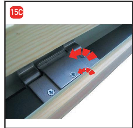
**IT** Riposizionare il battente facendo attenzione a posare le cerniere nelle apposite sedi. Il modo più agevole per riposizionare il battente è tenendo un angolo di apertura di circa 30°. **ATTENZIONE:** dopo avere posizionato le cerniere reggere il battente tramite la maniglia e incastrare l'estremità del pistone nella apposita sede. Riposizionare le piastrine di bloccaggio di entrambe le cerniere e fissarle con le viti rimosse al punto 3A e 3B.
