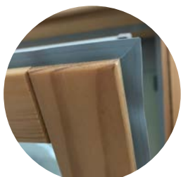
Guarnizione perimetrale del battente saldata agli angoli
