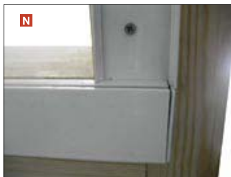
N O P Posizionare il profilo "a dx" a filo del tappo di chiusura e perfettamente verticale al profilo inferiore. Forare il profilo e fissarlo da entrambi i lati. Fare scattare il particolare "b dx" sul particolare "a dx" fino al completo inserimento. Ripetere tutte le operazioni per i particolari "a sx" e "b sx".
