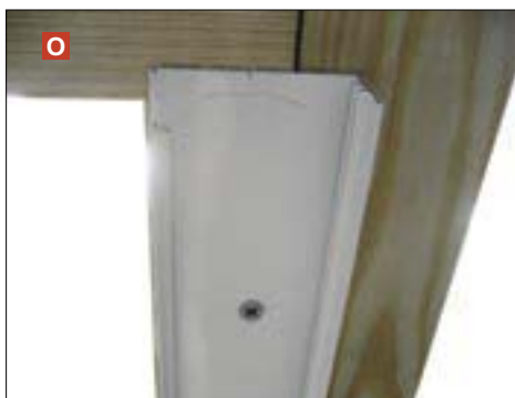
N O P Posizionare il profilo "a dx" a filo del tappo di chiusura e perfettamente verticale al profilo inferiore. Forare il profilo e fissarlo da entrambi i lati. Fare scattare il particolare "b dx" sul particolare "a dx" fino al completo inserimento. Ripetere tutte le operazioni per i particolari "a sx" e "b sx".
