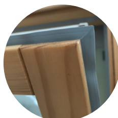
Guarnizione perimetrale del battente saldata agli angoli
