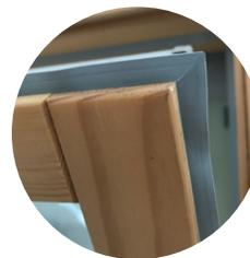
Guarnizione perimetrale del battente saldata agli angoli
