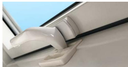
Particolare della maniglia in posizione di microventilazione
